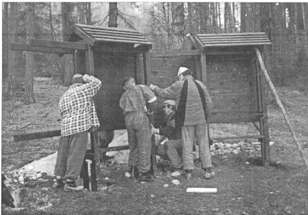
Instalace informační tabule u výchozího stanoviště při výstupu na Velký Blaník od Louňovic.
