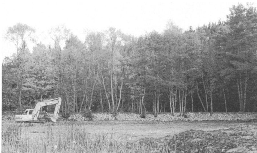
Foto: Obnova Malého Býkovického rybníka (součást Přírodní rezervace Podlesí), který biotopem řady ohrožených a zvláště chráněných druhů rostlin a živočichů. Byla opravena hráze, zrekonstruovány objekty hráze a odstraněn sediment ze 2/3 plochy rybníka (P. Pešout)
