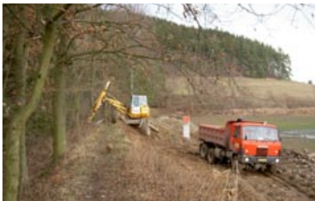
Oprava hráze Velkého Býkovického rybníka.
